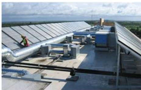
Fig. Solar Panel Installation Bewley’s Hotel
