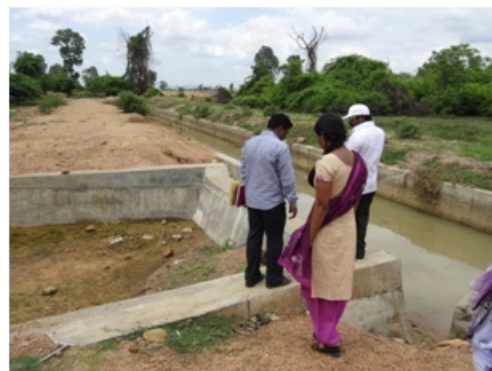
Fig (Outlet weir)
